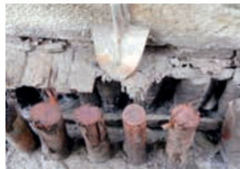
↑ Fig. 24.2 Pali di fondazione di un edificio storico a Venezia.
