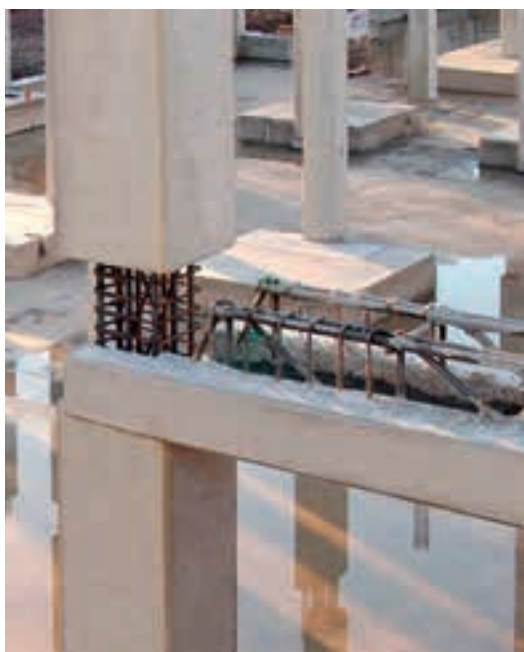
← Fig. 24.4 Congiunzioni tra pilastri verticali e travi orizzontali.
