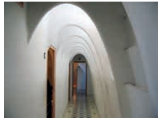
→ Fig. 24.57 Antoni Gaudí, archi parabolici nella Casa Batló. Barcellona.
