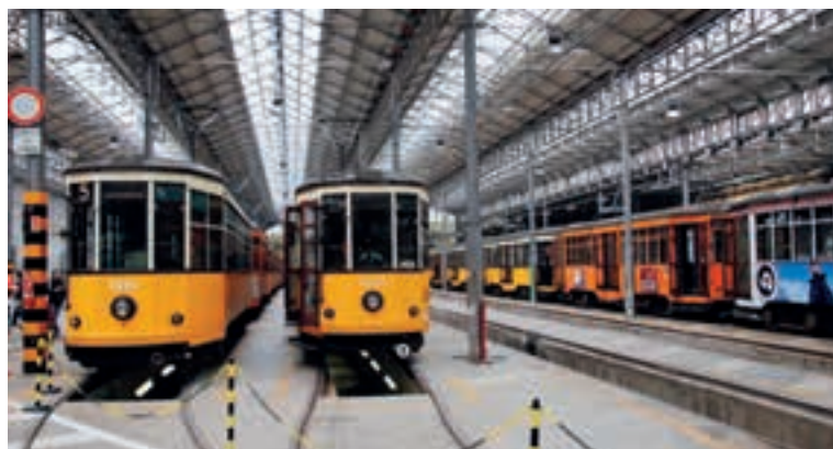
↓ Fig. 24.20 Capriate in metallo, Deposito Atm di Via Messina, 1912. Milano.
