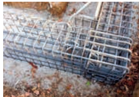
↑ Fig. 24.3 Nodo in fondazione tra travi ortogonali in cemento armato.
