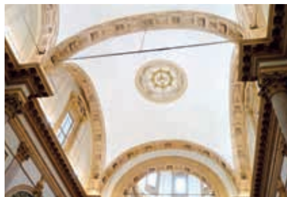
→→ Fig. 24.84 Filippo Brunelleschi, Basilica di Santo Spirito, dal 1428 ca. Firenze. Particolare dell'interno con le volte a vela.
