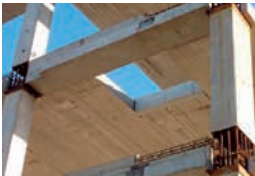
↑ Fig. 24.8 Solai in cemento armato interni al telaio di un edificio in costruzione.
