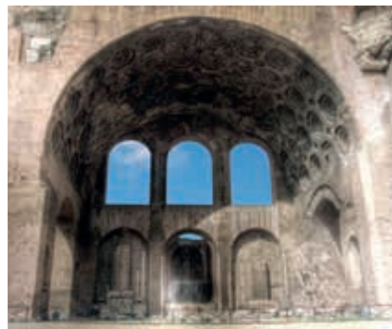
→ Fig. 24.59 Volta a botte cassettonata. Particolare dalla Basilica di Massenzio a Roma.
