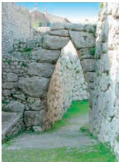
↑ Fig. 24.37 Falso arco (sovrapposizione di pietre), mura poligonali di Arpino (Frosinone).
