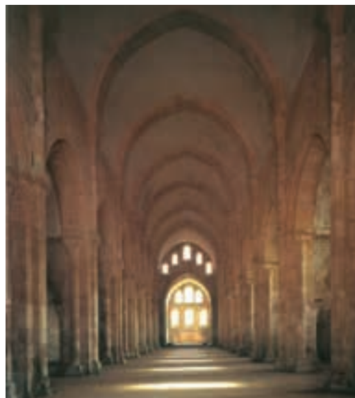
→ Fig. 24.60 Volte a botte a sesto acuto nell'Abbazia di Fontenay (Francia).
