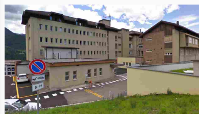
Da oggi una settimana di lavori all'ospedale di Cavalese
