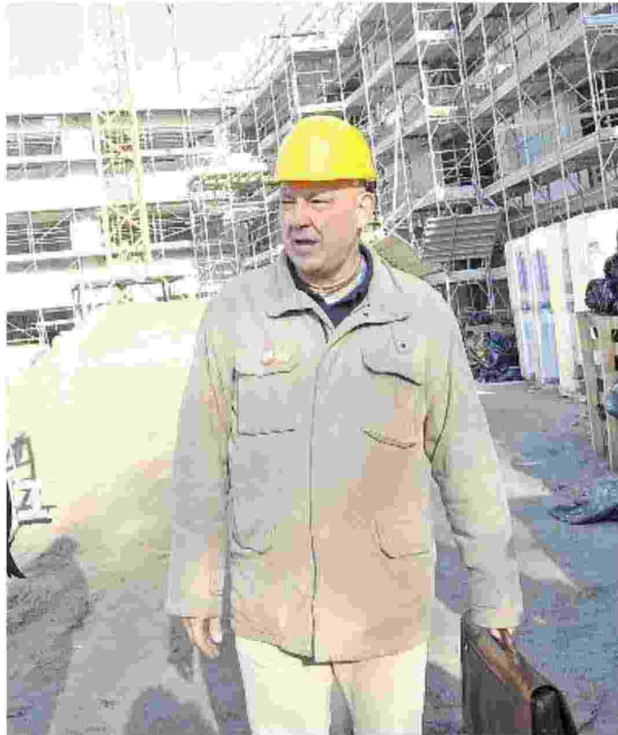
L'assessore Paolo Limonta durante un sopralluogo nel cantiere della scuola di via Pisa
